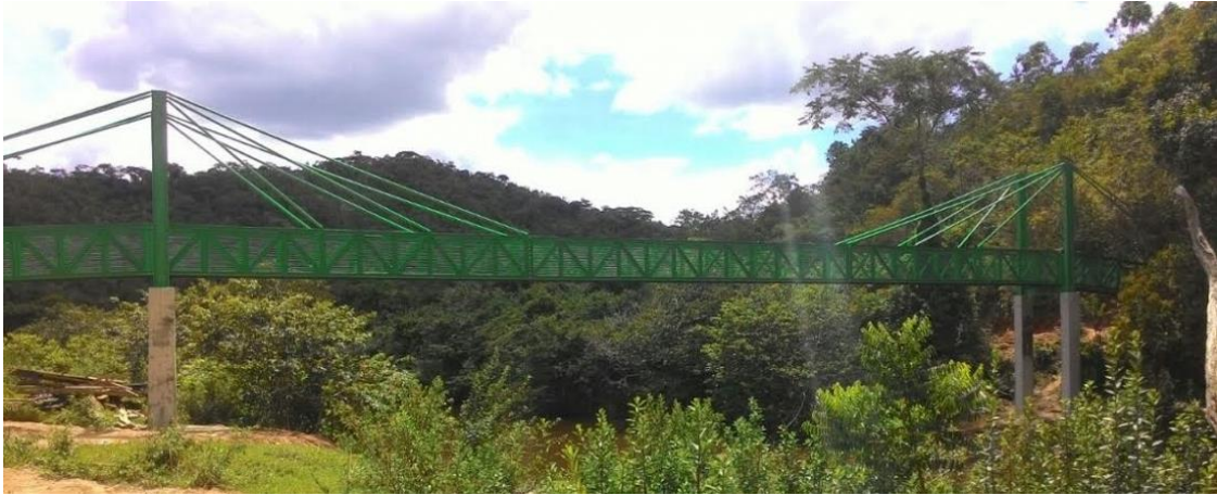
ECOPASSARELA: 58,00 x 1,50 metros. Defesa: guarda corpo metálico.
