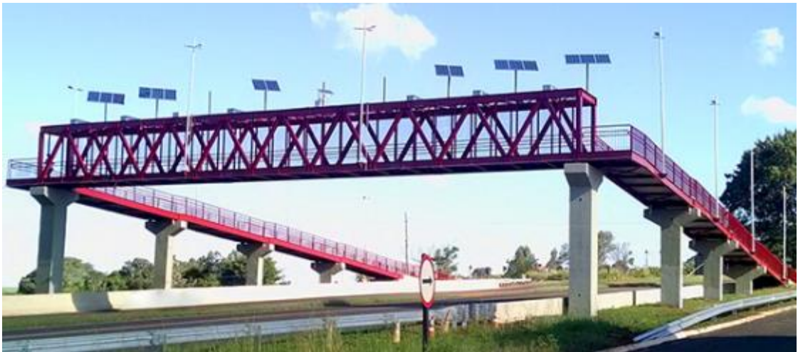
ECOPASSARELA: 20,00 x 2,50 metros. Defesa: guarda corpo metálico.
