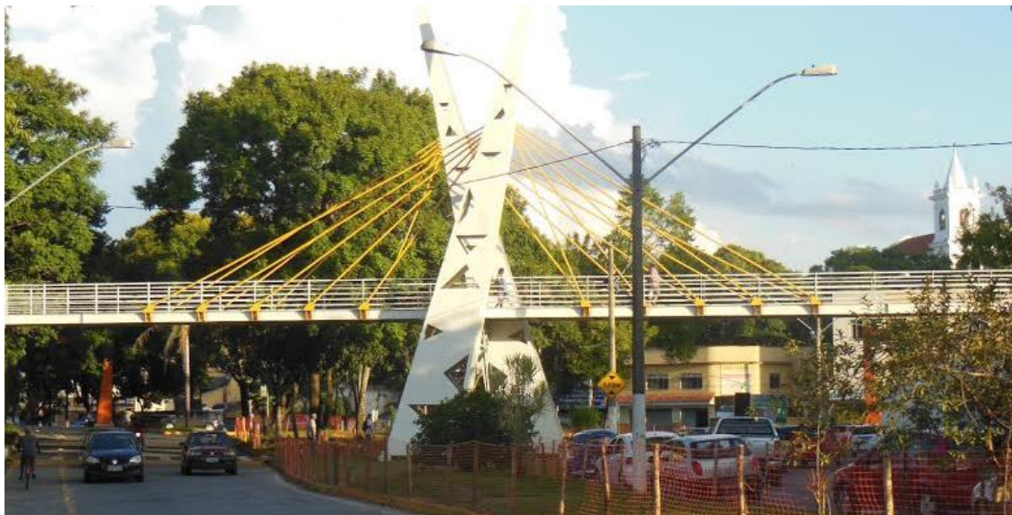
ECOPASSARELA: 45,00 x 5,00 metros. Defesa: guarda corpo metálico.
